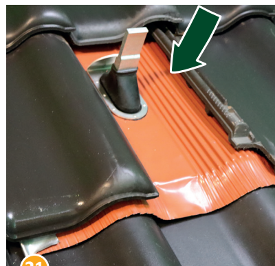
21 Dacheindeckung wieder vervollständigen.
