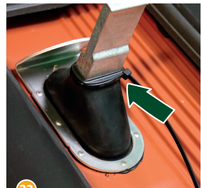
22 Die Oberseite der Dichtmanschette mit Hilfe des Kabelbinders zusätzlich sichern. Hierzu den Kabelbinder in die Nut einpassen, die Lasche des Kabelbinders an einer der vier Ecken der Manschette platzieren, festziehen und den überstehenden Rest abschneiden.
