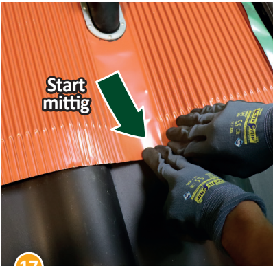
17 Von der Mitte an beginnend nach außen fest und formschlüssig andrücken....
