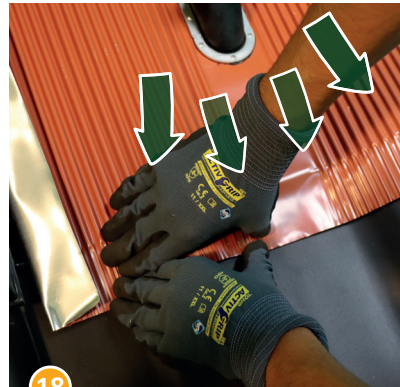
18 ...dabei wieder darauf achten, dass sich im mittleren und oberen Bereich keine Wassersäcke bilden.
