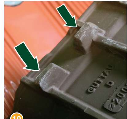
19 Die Verriegelungsnasen auf der Rückseite der einzuhängenden Tonziegel....
