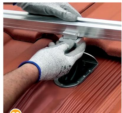
22 Die Klemmkombination wieder auf die Konsole stecken, das Tragprofil auflegen, einhängen, dabei die Höhe durch die Klemmkombination an der Konsole anpassen...
