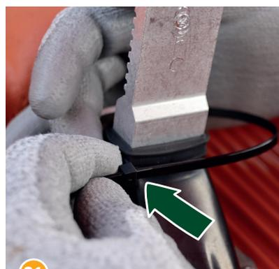
21 Die Oberseite der Dichtmanschette mit Hilfe des Kabelbinders zusätzlich sichern. Hierzu den Kabelbinder in die Nut einpassen, die Lasche des Kabelbinders an einer der vier Ecken der Manschette platzieren, festziehen und den überstehenden Rest abschneiden.
