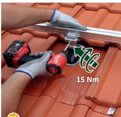
23 ...und die Position durch Anziehen der Schraube fixieren (15 Nm).
