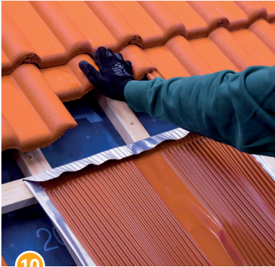
10 Dacheindeckung über Beta-Platte aufdecken.
