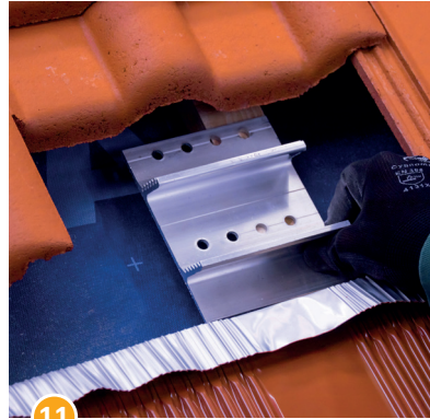
11 Fuß des Dachhakens auf dem Dachsparren ausrichten.
