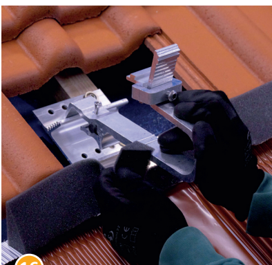
16 Dachhaken in Fuß einhängen.
