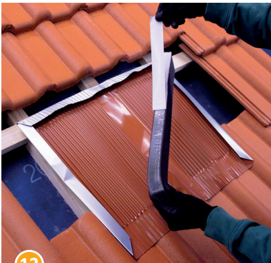
13 Schutzfolie des Klebestreifens auf der Unterseite des Schaumstoffkeils abziehen.
